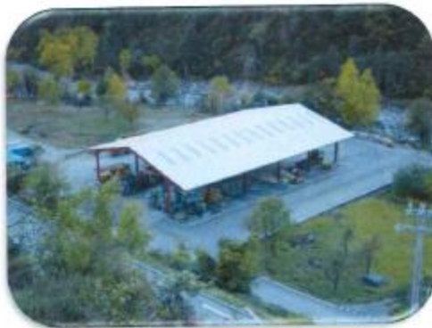
- Hangar de stockage matériel
