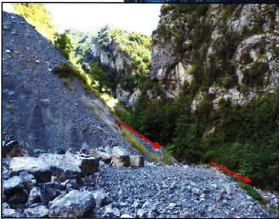
Glissements de matériaux dans le Vallon de Bramafan
